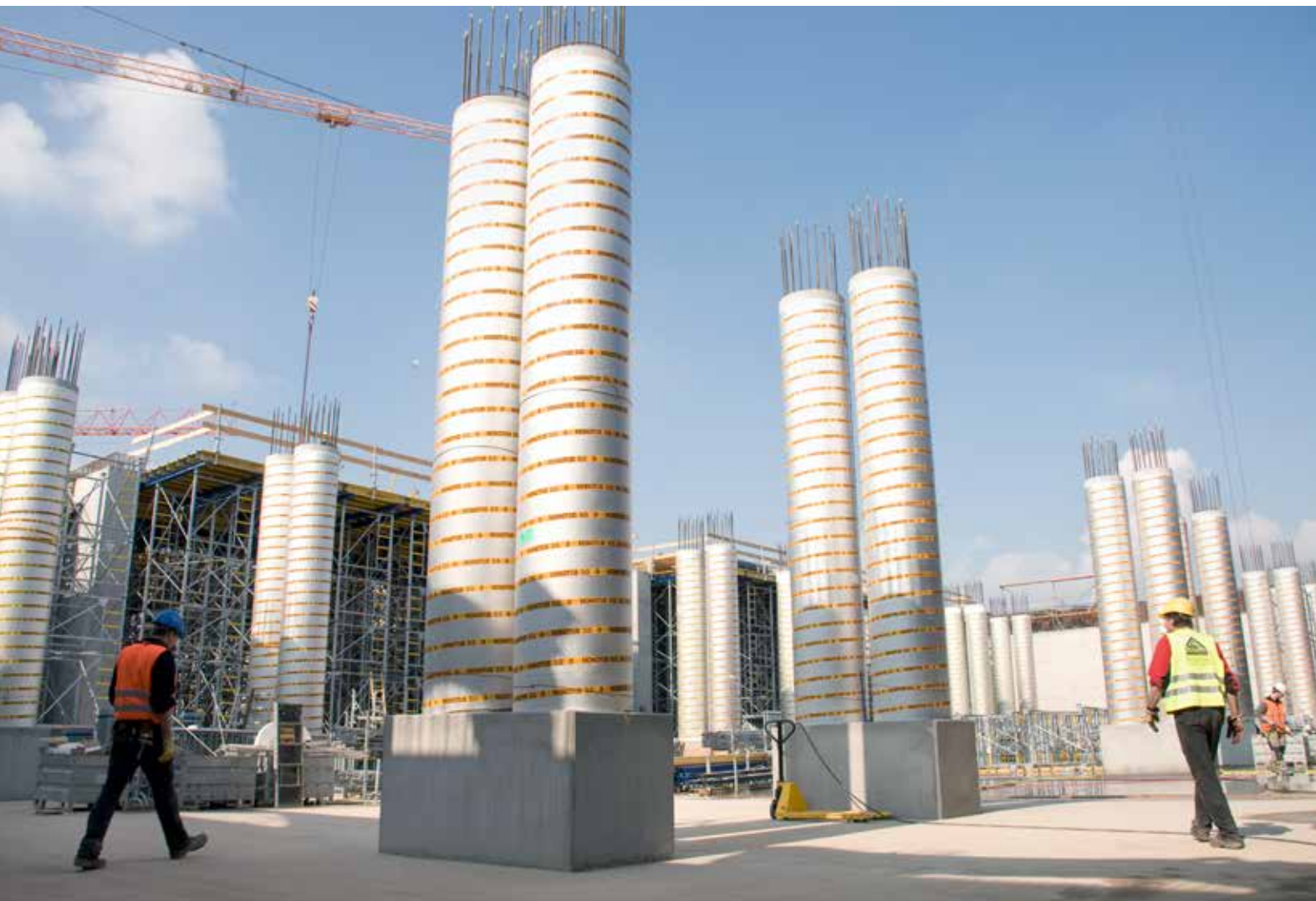
Noch haben die frisch gesetzten Betonstützen nichts zu tragen außer sich selbst...
