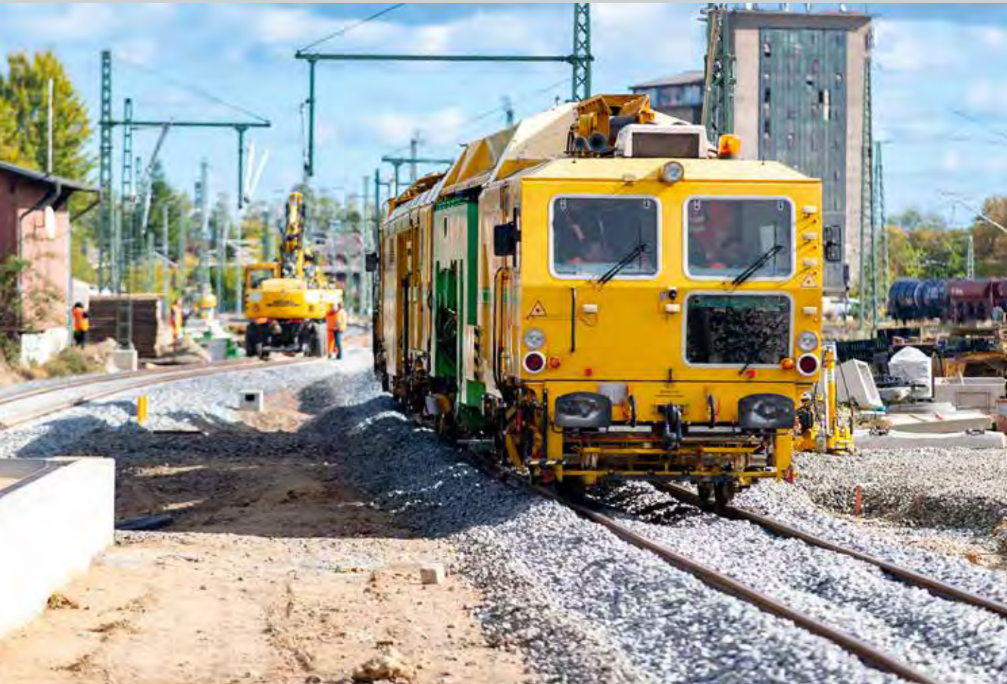
Die BUG Verkehrsbau SE ist heute Komplettanbieter im Bahnbau und der Bahnausrüstung
