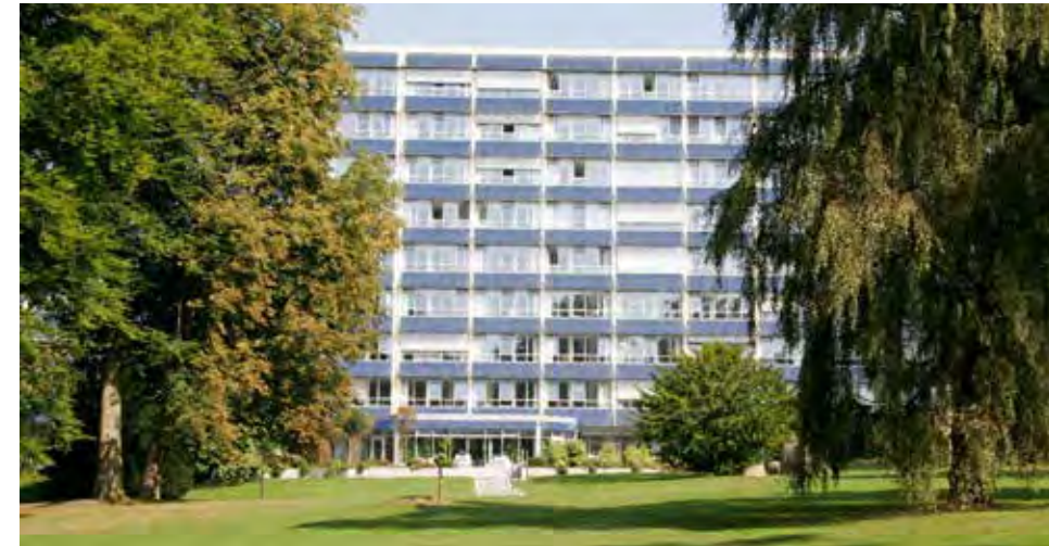
Das derzeitige Bettenhaus der Lungenklinik ist zwar mehrfach modernisiert worden, bald aber wird es durch einen Neubau ersetzt
