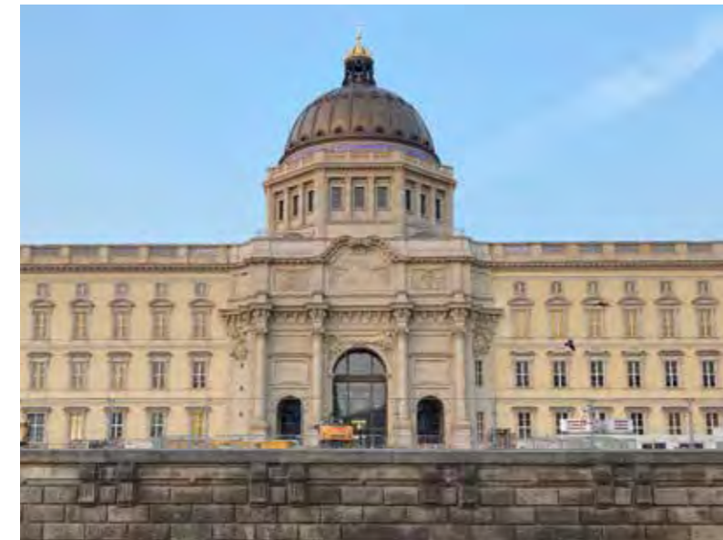
Das Eosander-Portal am Berliner Stadtschloss ist soeben fertig geworden. Um Putz und Stuck innen wurde noch gestritten
