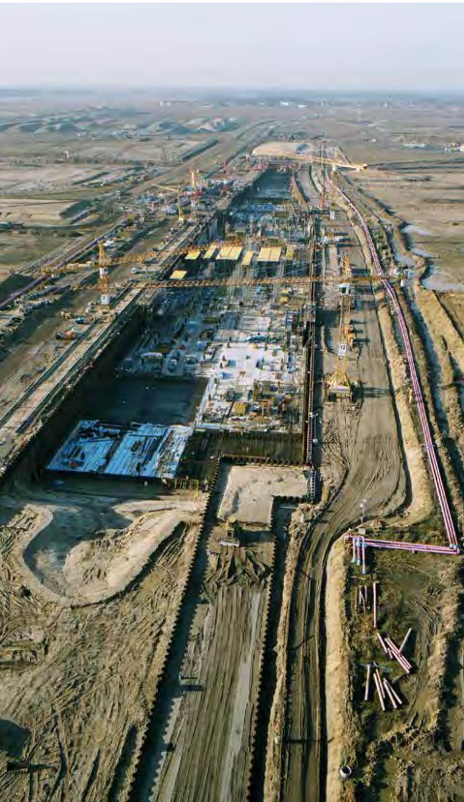
Der unterirdische Flughafenbahnhof entsteht
