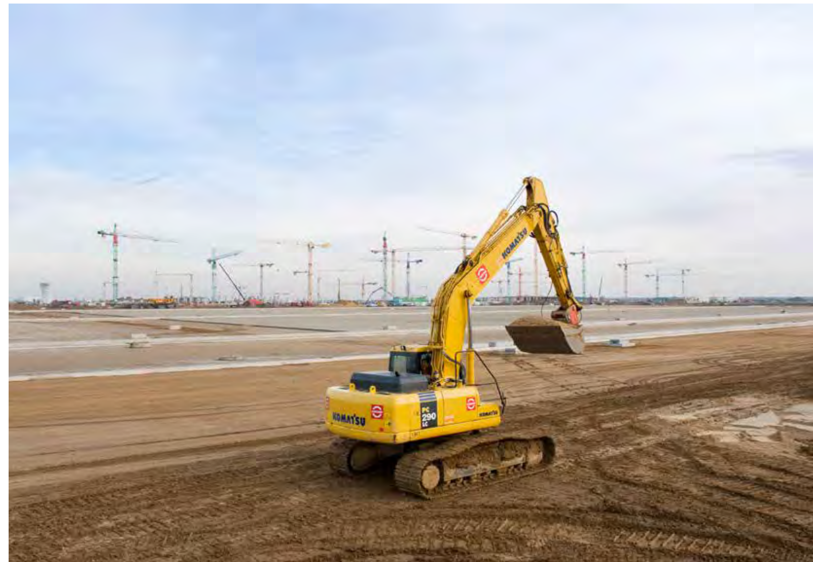
Mit Baggern fängt es an: ausheben, verteilen, planieren – für perfekte Betriebsflächen
