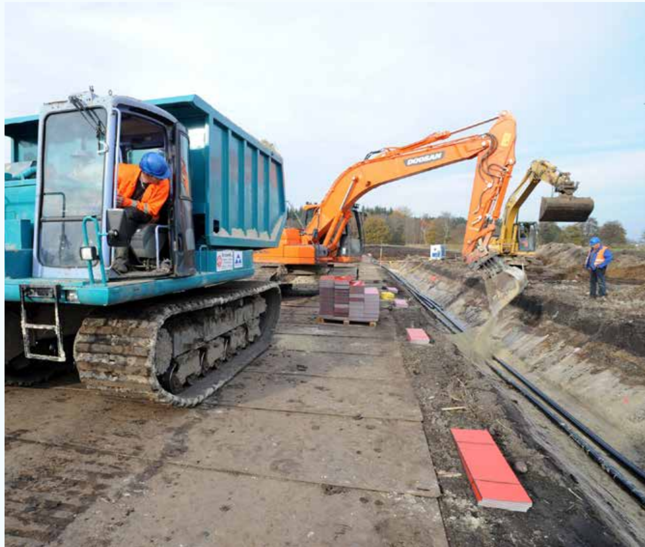
Kabelverlegung für eine Hochspannungs-Übertragungsleitung: Die in den ausgehobenen Gräben eingelegten Spezialkabel werden erst mit einer besonderen Schüttung überdeckt, bevor Bagger den Graben mit Boden wieder auffüllen
