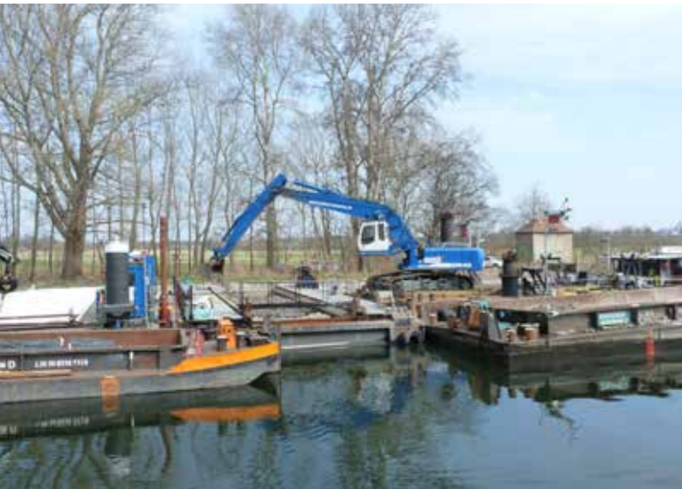
Schonprogramm für alte Bäume: Die Baggerarbeiten am Nordufer wurden vom Wasser aus erledigt
