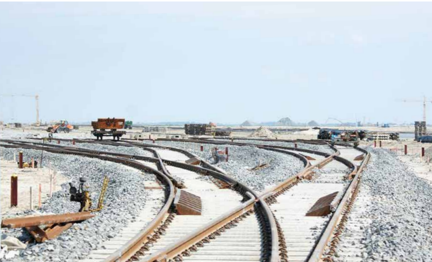
Neubau von Gleisen für einen Hafenanchluss am Jade-Weser-Port in Wilhelmshaven
