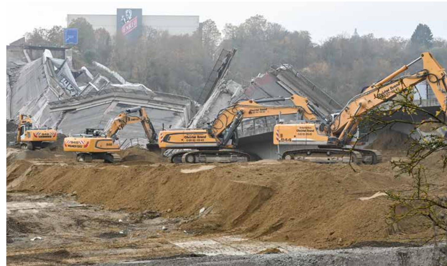
Nach Sprengung der Salzachtalbrücke der A66 bei Wiesbaden beginnen Bagger damit, die Reste des maroden Bauwerks zu beseitigen
